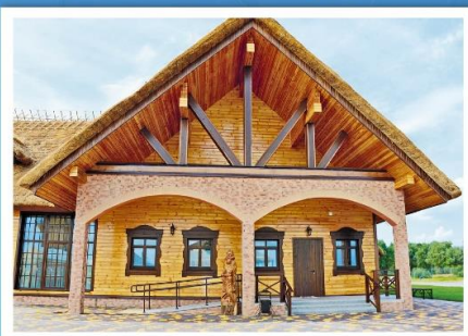
Строительство объектов «Музея под открытым небом» в Национальном парке «Припятский»
