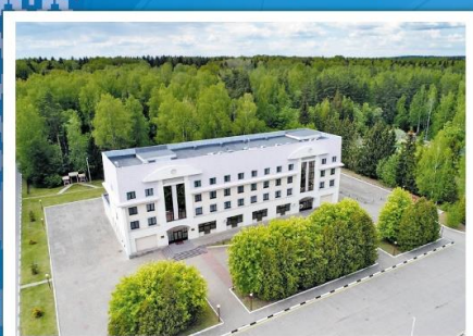
Капитальный ремонт гостиничного комплекса «Серуч» в Березинском биосферном заповеднике
