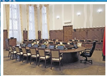
Ремонтно-строительные работы в зале заседаний Президиума Совета Министров Республики Беларусь
