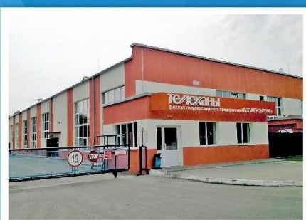
Реконструкция лыжного цеха филиала «Телеханы» ГП «Беларусьторг»
