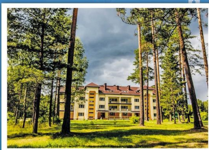
Капитальный ремонт с частичной реконструкцией корпуса №2 санатория «Боровое»
