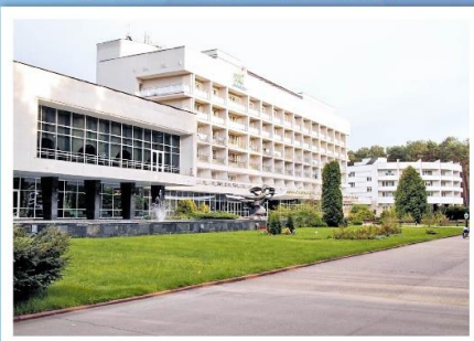
Капитальный ремонт с модернизацией главного корпуса санатория «Сосны»
