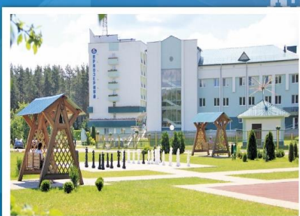
Реконструкция корпуса в санатории «Приозерный»
