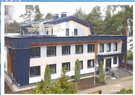
Реконструкция административного здания Национального парка «Браславские озера»
