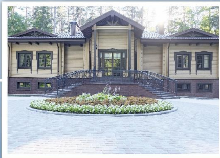
Возведение гостевого дома
