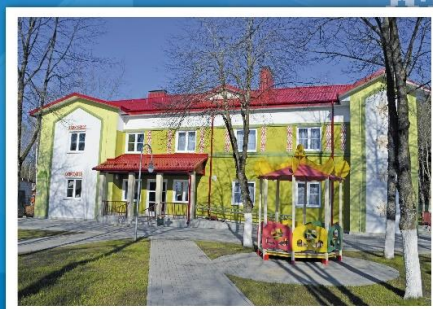
Реконструкция спального корпуса №3 в ДОЛ «Планета»
